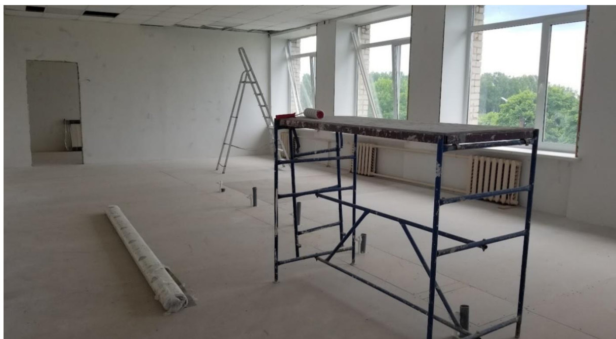
Фото 1. Этап демонтажа пола, дверей, выравнивания стен.
