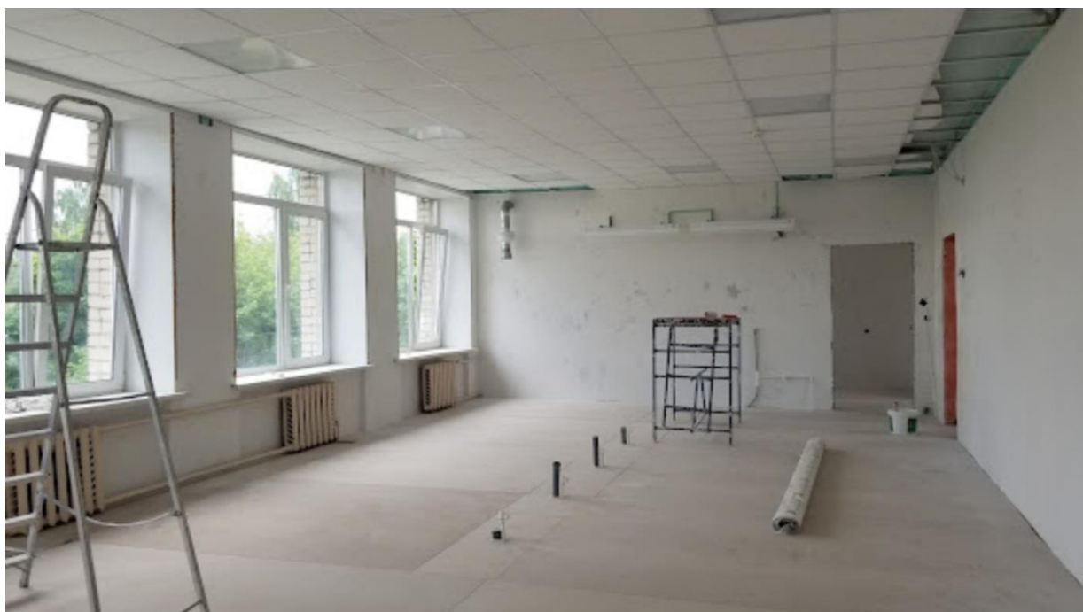
Фото 2,3. Стены и пол подготовлены к этапу финишной отделки.
